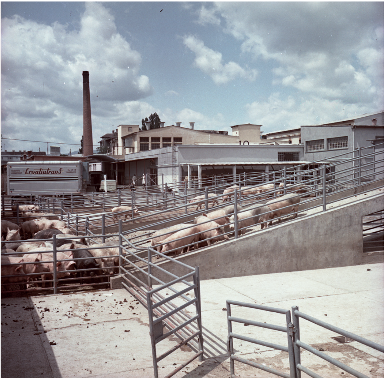
Pogled na tvornicu s istočne strane, 1961. (HR-HDA-1422, Co-1186-034)
