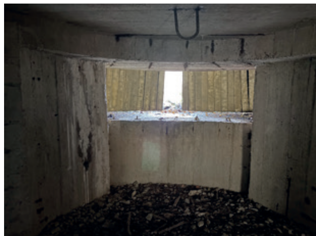
Unutrašnjost toparnice teškog protutenkovskog bunkera br. 17
