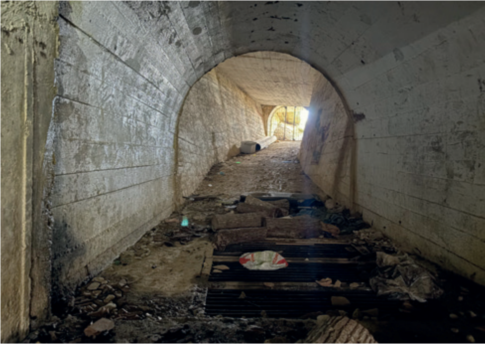
Ulazni tunel teškog protutenkovskog bunkera br. 18
