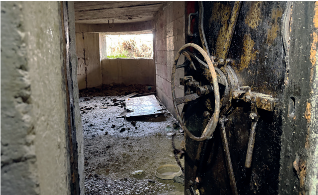
Unutrašnjost teškog protutenkovskog bunkera br. 18
