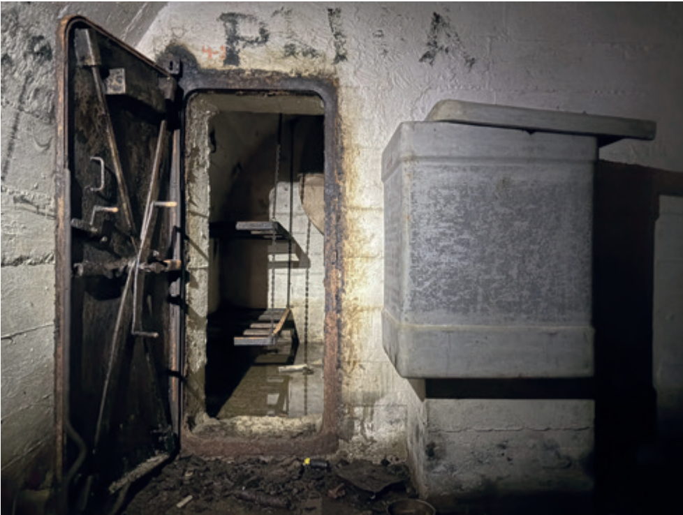
Unutrašnjost teškog protutenkovskog bunkera br. 17
