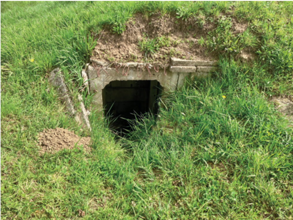
Ulaz lakog strojničkog bunkera (Resnički gaj)
