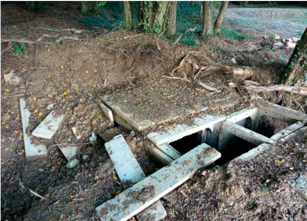
Laki strojnički bunker nakon uklanjanja zemlje i kamenja (Markovo Polje)
