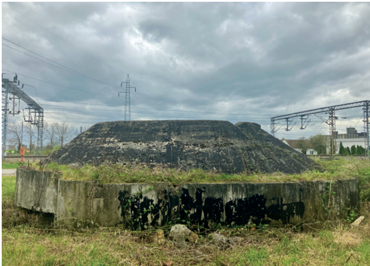
Teški protutenkovski bunker br. 9
